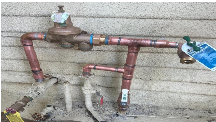
2-расм. Турар-жой биноси ички сув таъминоти тизимининг кириш қисми: сув ҳисоблагич, редуктор ва запор арматураси
