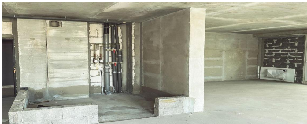
1-расм. Кўп қаватли турар-жой биносида ички сув таъминоти ва канализация тизимининг вертикал стояги (монтаж жараёни)
