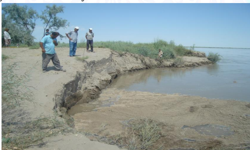
2-rasm. Amudaryoda joylashgan №21 dambaning quyi tomonining yuvilishi
