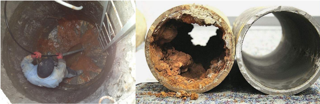
Kanalizatsiya tizimida tiqilinch hosil qilgan yog'lar (1-rasm)
