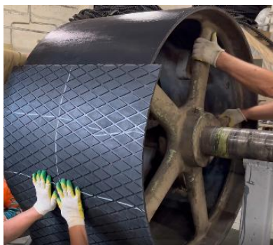
3-расм. Барабанга футеровкани ёпиштириш ва болғалаш
